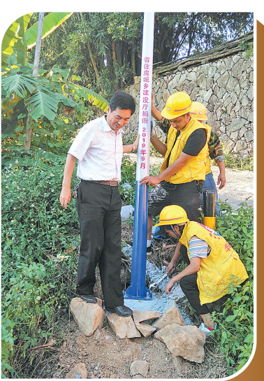
驻村第一书记与工人一起安装太阳能路灯
