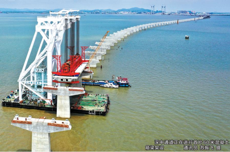
深中通道正在进行首片60米混凝土箱梁架设 通讯员 苏振飞 摄
