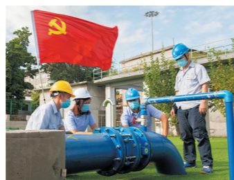
广州水投广州自来水公司工作人员检查供水设施 梁毅摄
