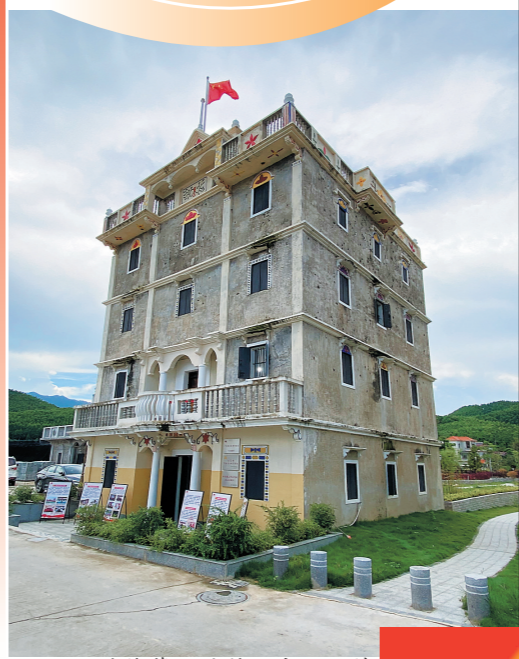
经过修缮后的鹤山市址山镇云乡张怀楼,目前已成为云乡革命史迹陈列馆
