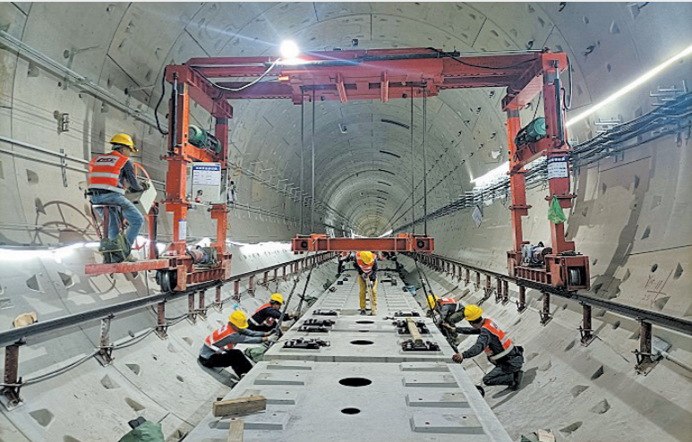
广州地铁二十二号线首通段进行铺轨作业
