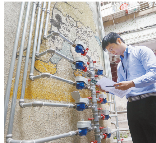
市自来水工作人员检查改造后的自来水管网
