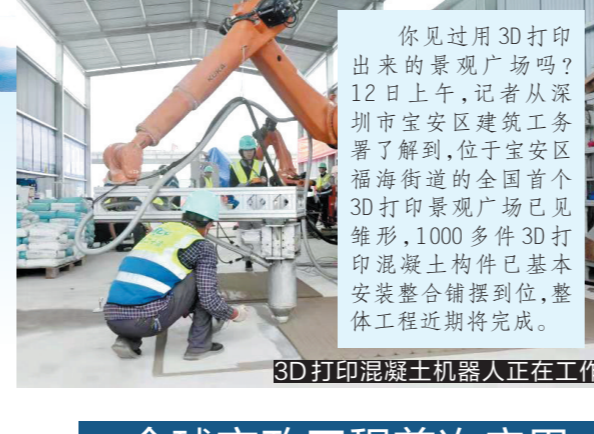
3D打印混凝土机器人正在工作
