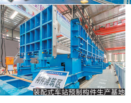
装配式车站预制构件生产基地
