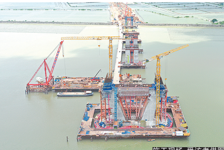
施工现场 受访者供图
