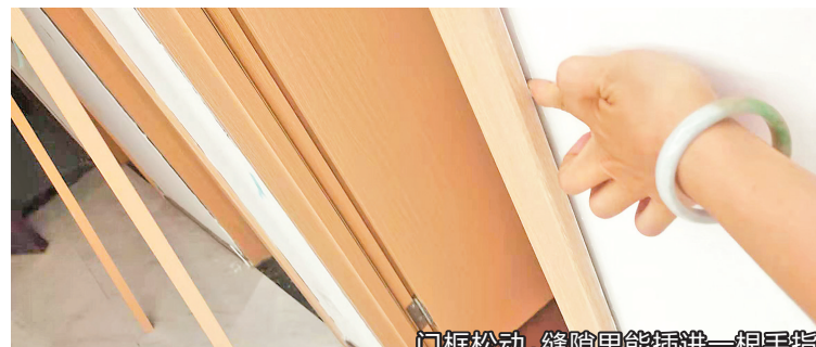
门框松动,缝隙里能插进一根手指
