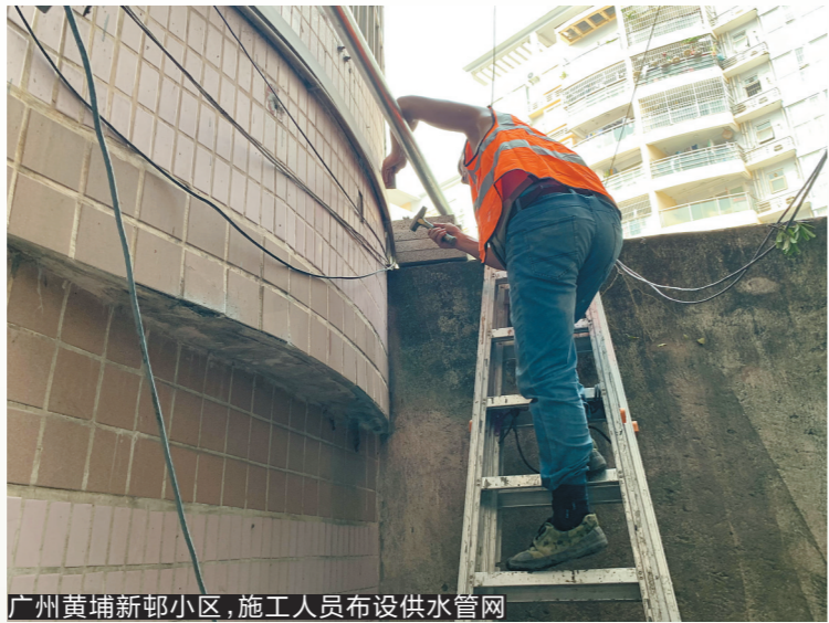
广州黄埔新邨小区,施工工人布设供水管网
