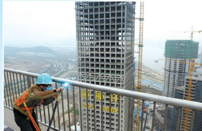
横琴总部大厦楼顶工人们正在作业,旁边已 是高楼林立 羊城晚报记者 林桂炎 摄
