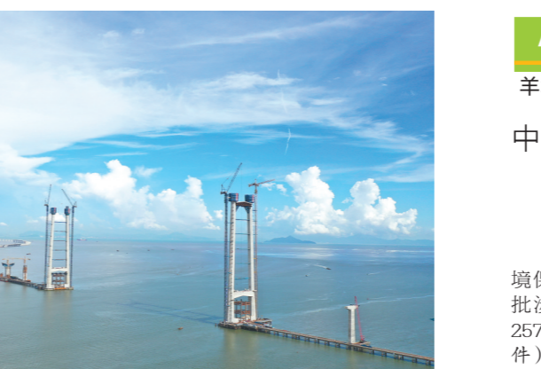
环树脂涂层钢筋等防腐措施外,还为混凝土外层喷涂了防止海水侵蚀的“防护服”——硅烷浸渍剂。
