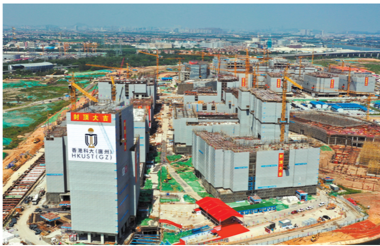
9月26日,香港科技大学(广州)项目一期工程核心建筑和配套建筑主体结构迎来全面封顶 刘伟 摄
