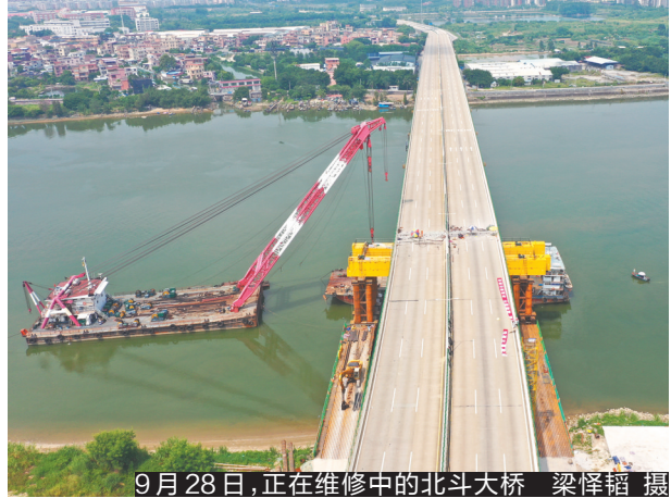
9月28日,正在维修中的北斗大桥。梁肇韬 摄
