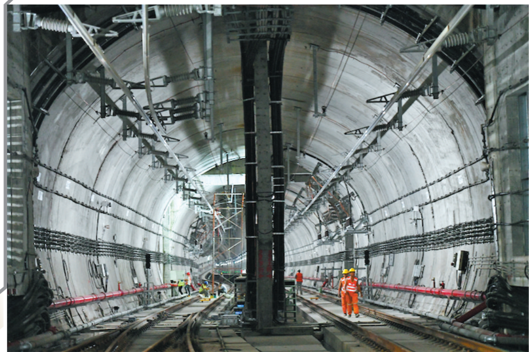
建设中的广州地铁18号线隧道内部
