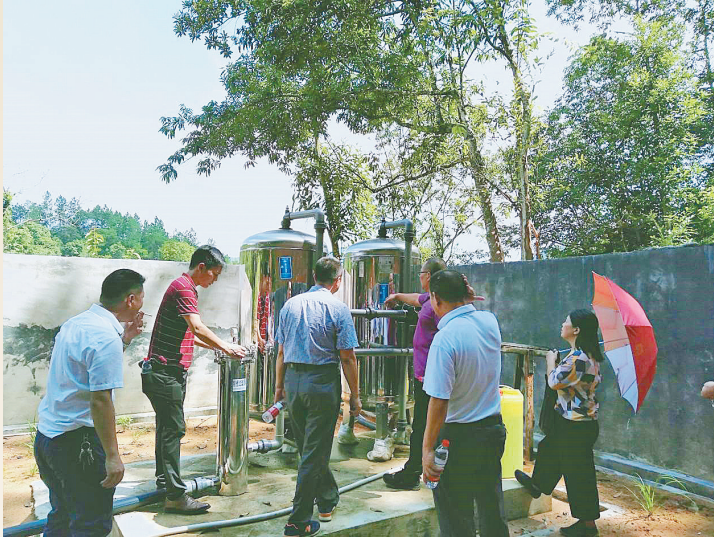
自来水设备正在安装中
