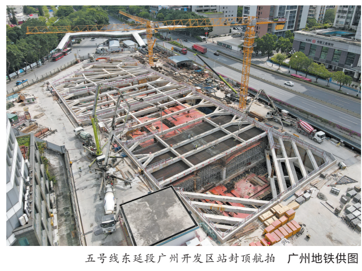
五号线东延段广州开发区站封顶航拍 广州地铁供图
