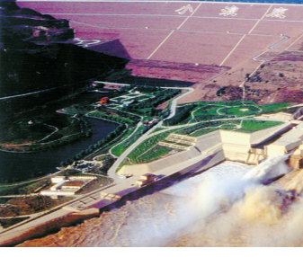
水电六局重点工程之小浪底水利枢纽 水电六局供图
