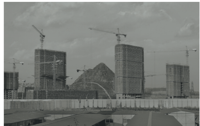
2017年11月，在拆除的石门村废墟上，一栋栋高楼拔地而起
