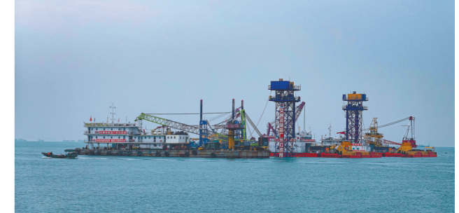
10月31日晚,在深圳侧东人工岛水下互通立交,深中通道沉管隧道超宽、变宽管节E30完成精准对接
