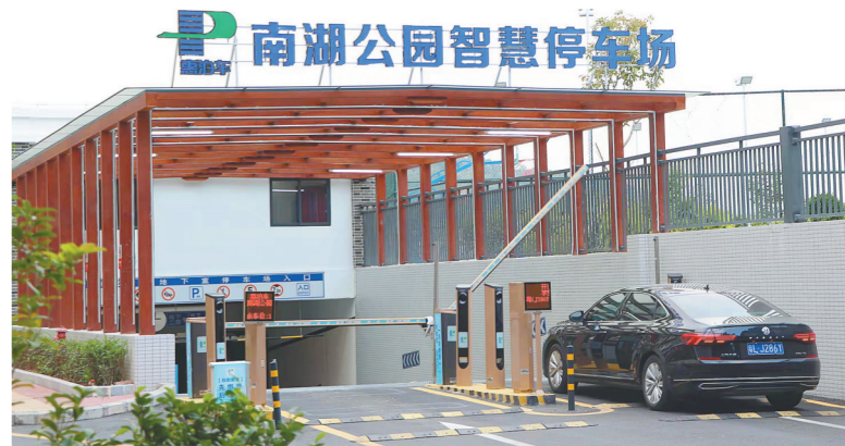
南湖公园智慧停车场提供360个车位,有效缓解停车难问题
