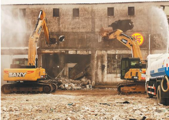
钩机进场将河西片区破旧厂房拆除
