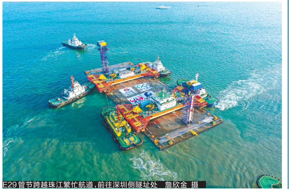
E29管节跨越珠江繁忙航道，前往深圳侧隧道处。詹欣金 摄
