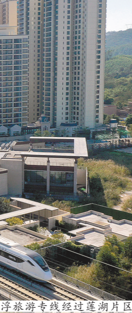
清远磁浮旅游专线经过莲湖片区
