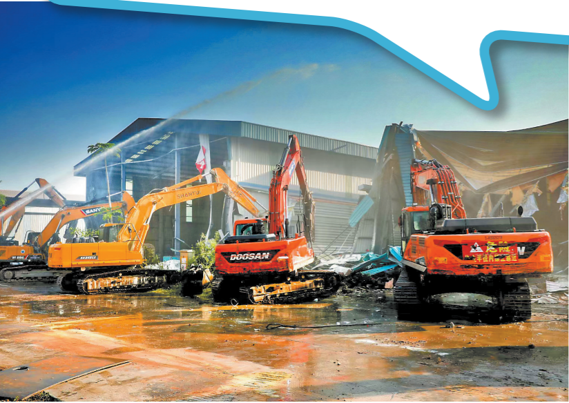
清拆老旧工业园
