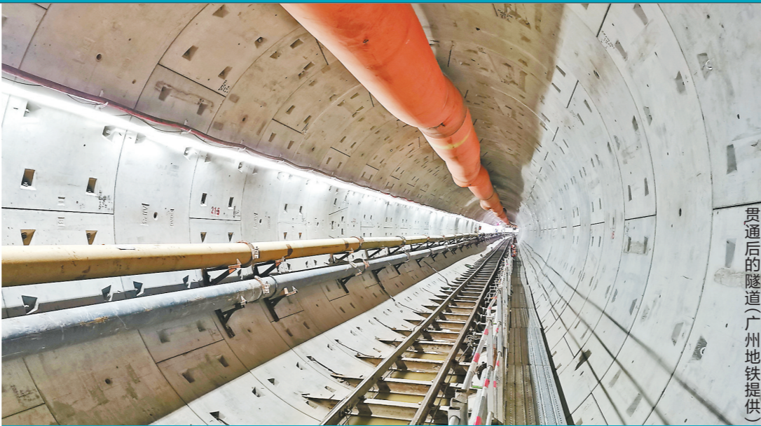
贯通后的隧道(广州地铁提供)
