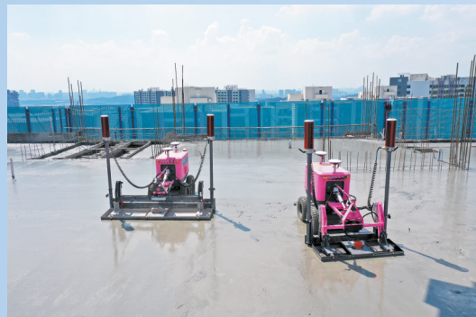
地面平整机器人作业中
