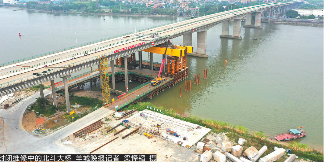
封闭维修中的北斗大桥。羊城晚报记者 梁驿韬 摄
