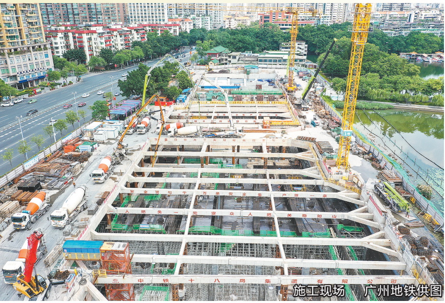
施工现场 广州地铁供图
