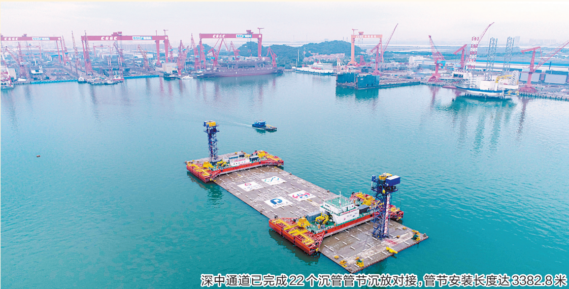
深中通道已完成22个沉管管节沉放对接,管节安装长度达3382.8米
