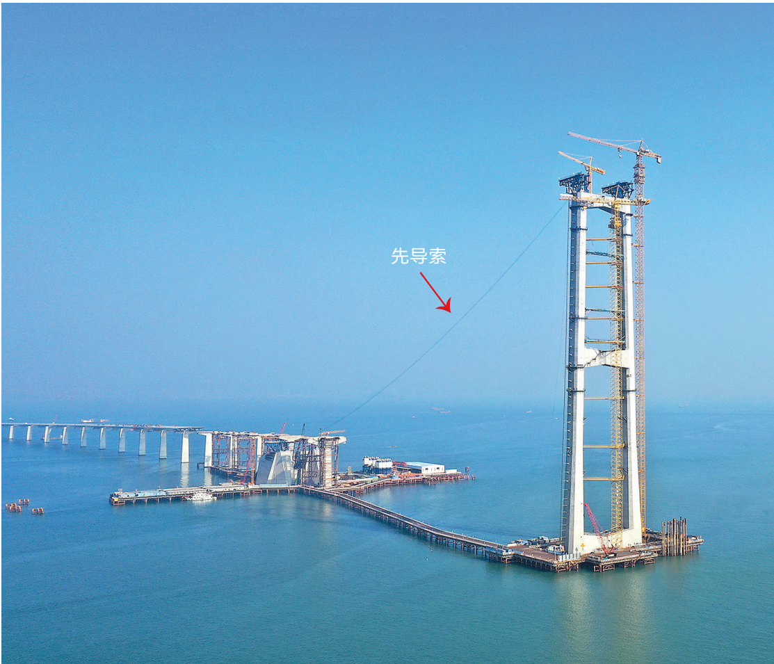
深中通道伶仃洋大桥先导索顺利过江 张政 摄
