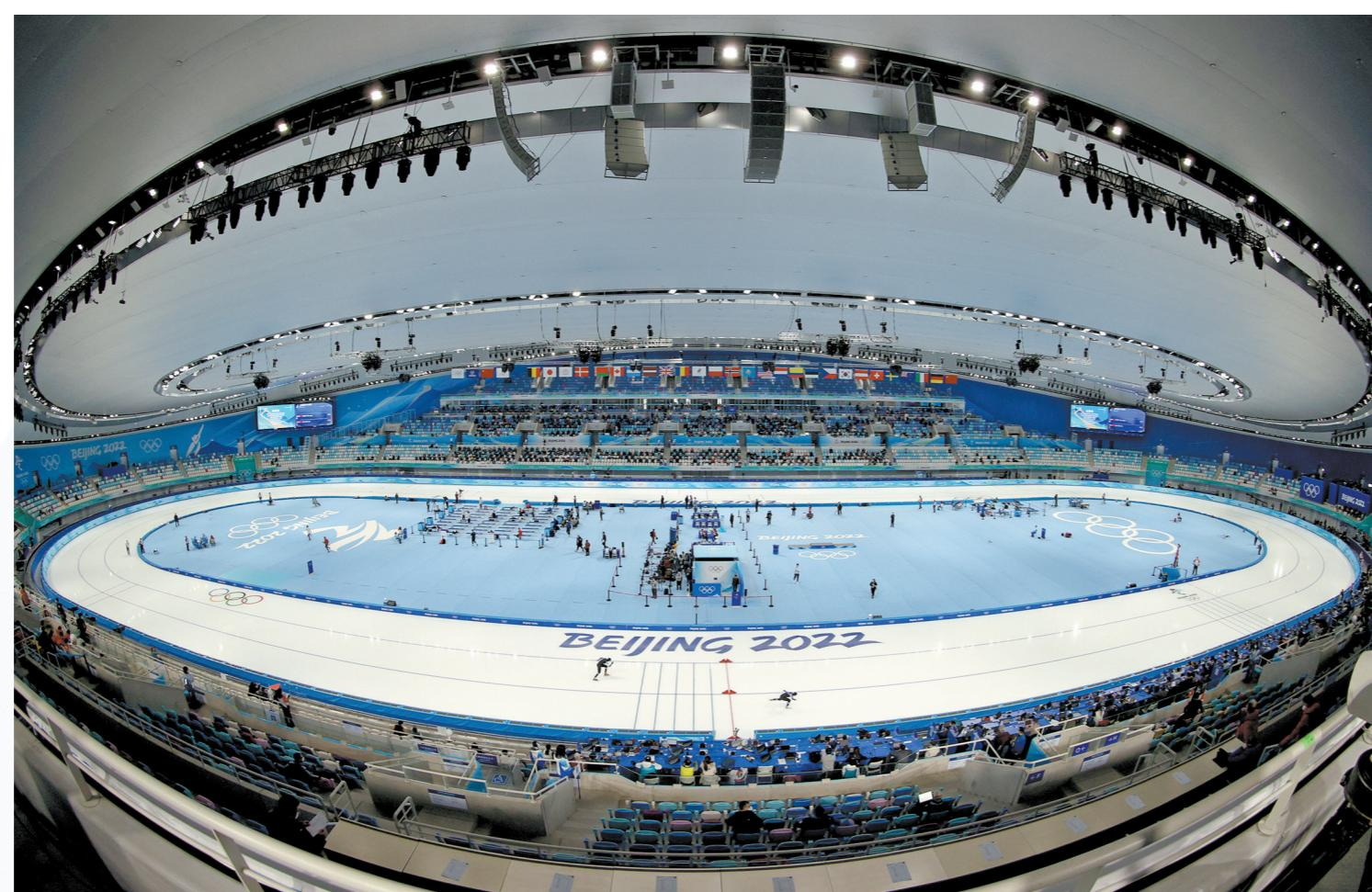
国家速滑馆“冰丝带”成为世界上第一座采用二氧化碳跨临界直冷系统制冰的大道速滑馆 图/视觉中国
