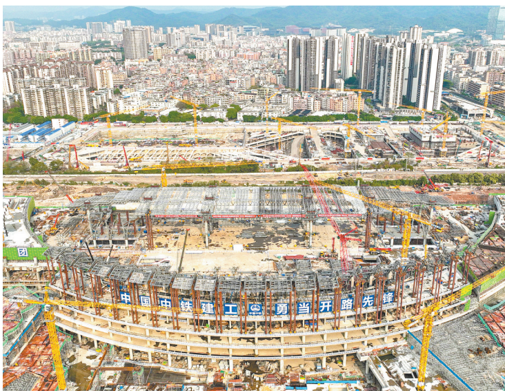
广州白云站一期工程屋盖钢结构提升施工现场
