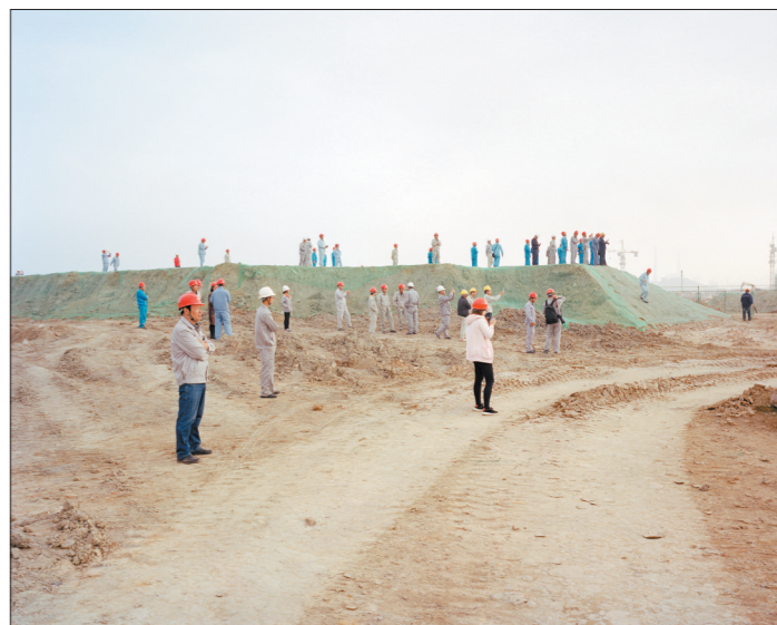
2019年1月15日，湛江东海岛，中科合资广东炼化一体化项目，最大设备(蒸汽裂解装置2号丙烯塔)吊装现场。丙烯塔吊装成功就位，在整个中科炼化一体化项目工程建设中具有里程碑意义。
