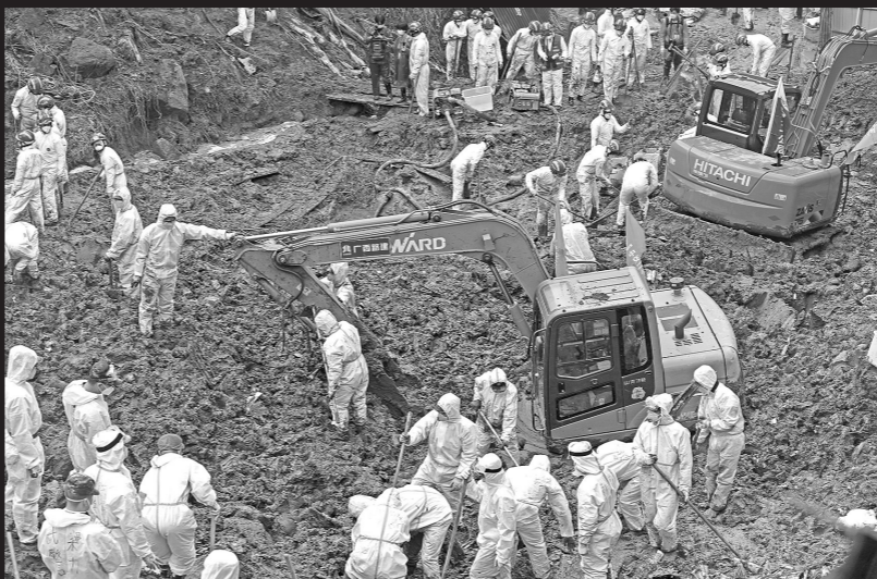
3月25日 大型机械进入现场开展工作
