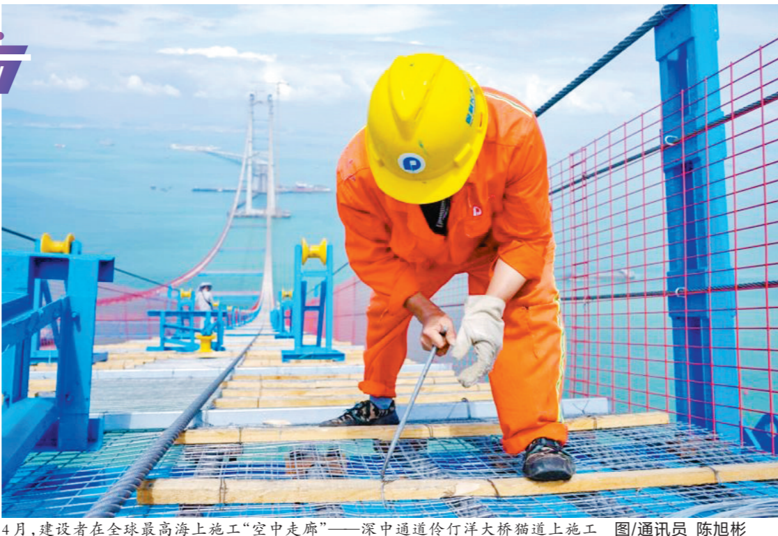
4月,建设者在全球最高海上施工“空中走廊”——深中通道伶仃洋大桥猫道上施工 图/通讯员 陈旭彬
