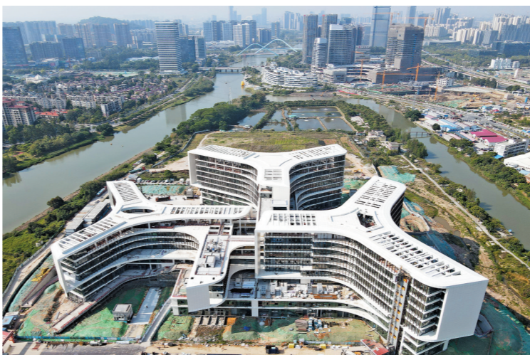
中铁建设承建的广州市妇女儿童医疗中心南沙院区
