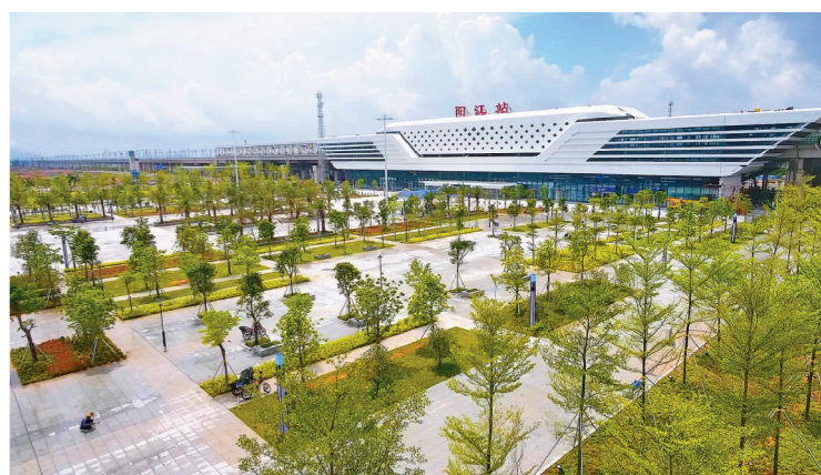
中铁建设承建的深茂铁路阳江站站房
