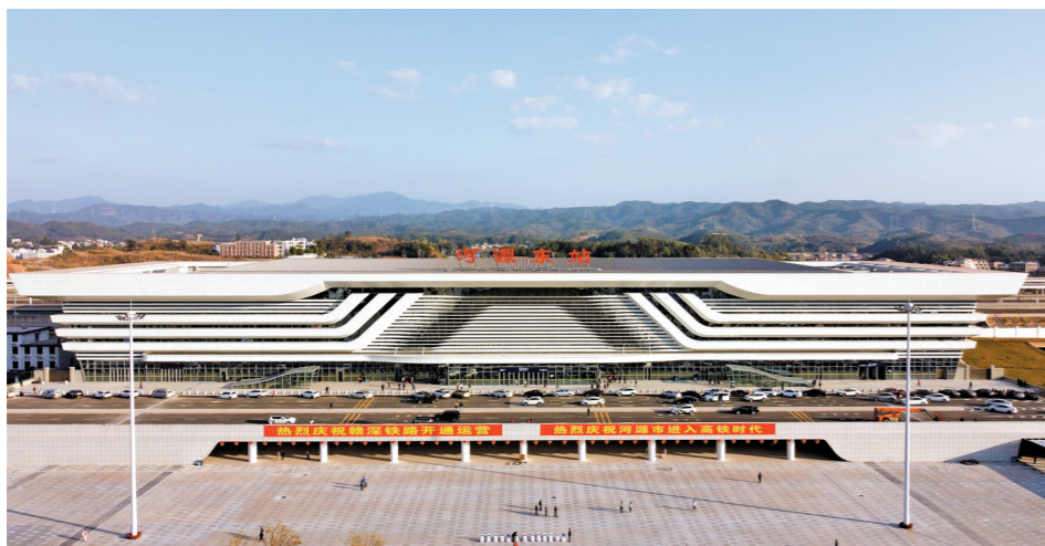
中铁建设承建的赣深铁路河源东站站房
