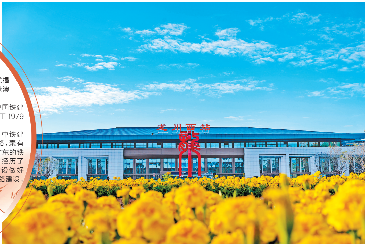
中铁建设承建的赣深铁路龙川西站站房
