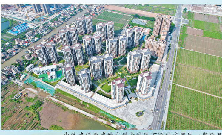
中铁建设承建的广州南沙区万顷沙安置区一期项目
