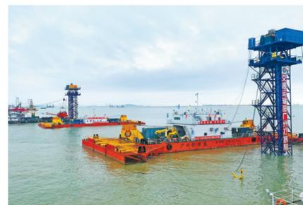
深中通道沉管隧道E25管节沉放安装
