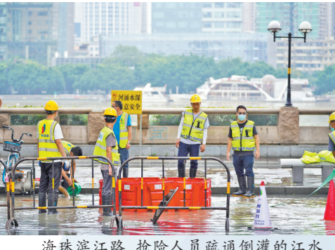
海珠滨江路，抢险人员疏通倒灌的江水
