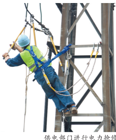
供电部门进行电力抢修
