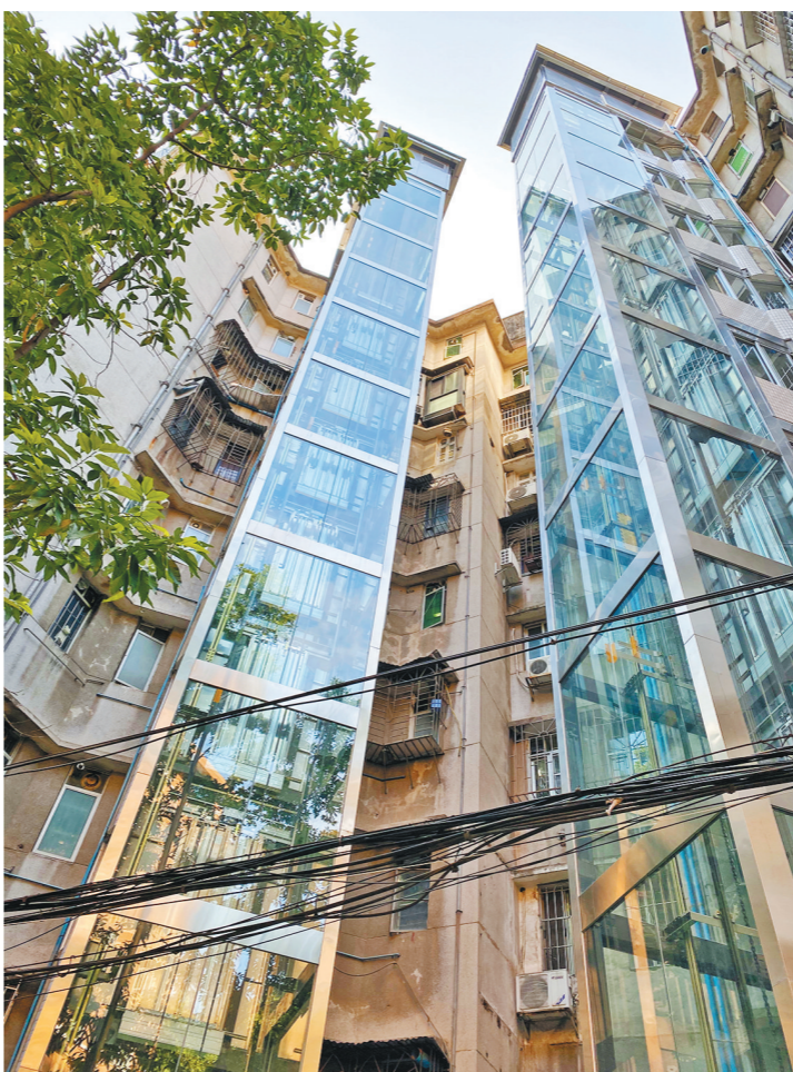
广州某老旧小区的加装电梯(资料图)
