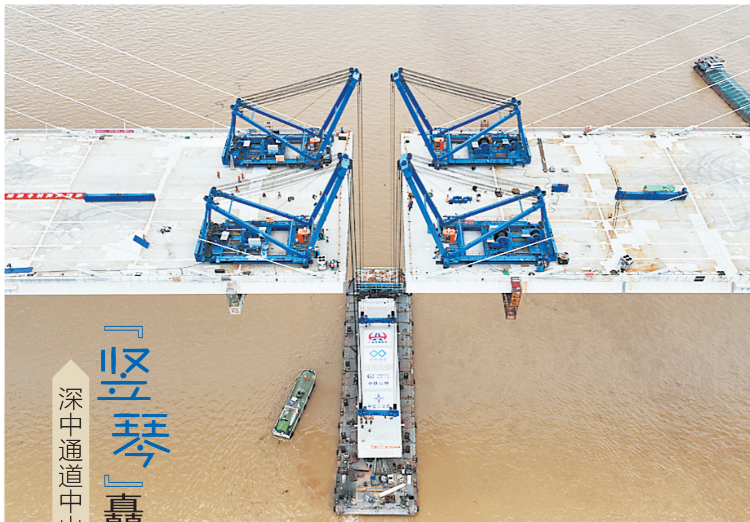
28日上午，深中通道中山大桥补上最后一块“积木” 通讯员 黄醒科 张佰承 摄
