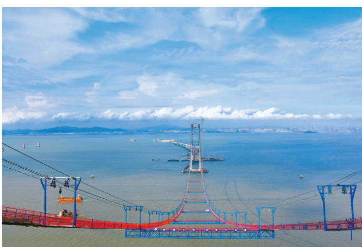
沈卫东拍摄的深中通道建设中的深中通道 受访者供图
