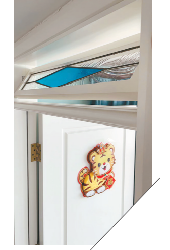
门顶可开天窗设计，可实现室内空气流通 嘉华设计供图
