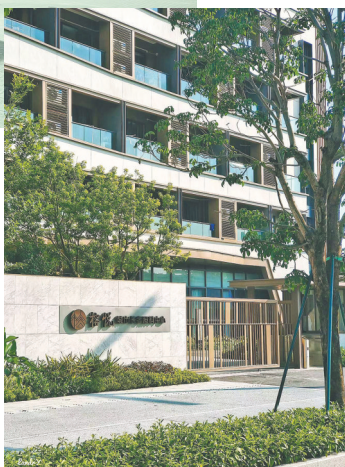
万科黄埔新城内的颐养中心已整体完成并亮灯
