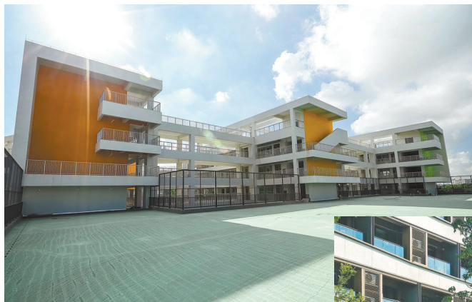
楼盘内的42班小学已基本完工
