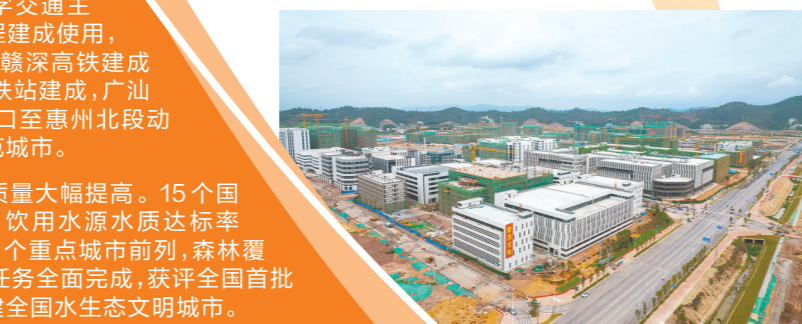
建设中的潼湖生态智慧区 钟泽民 摄
