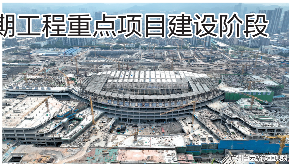
广州白云站施工现场
