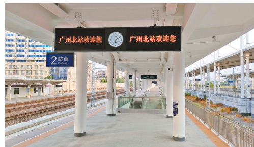
装修一新的二站台
