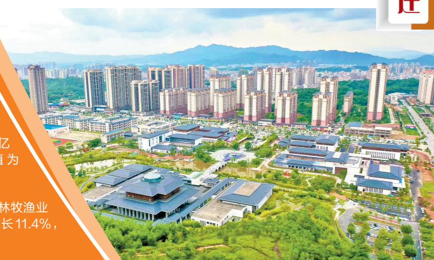
新兴县文化地标“四馆两中心”
