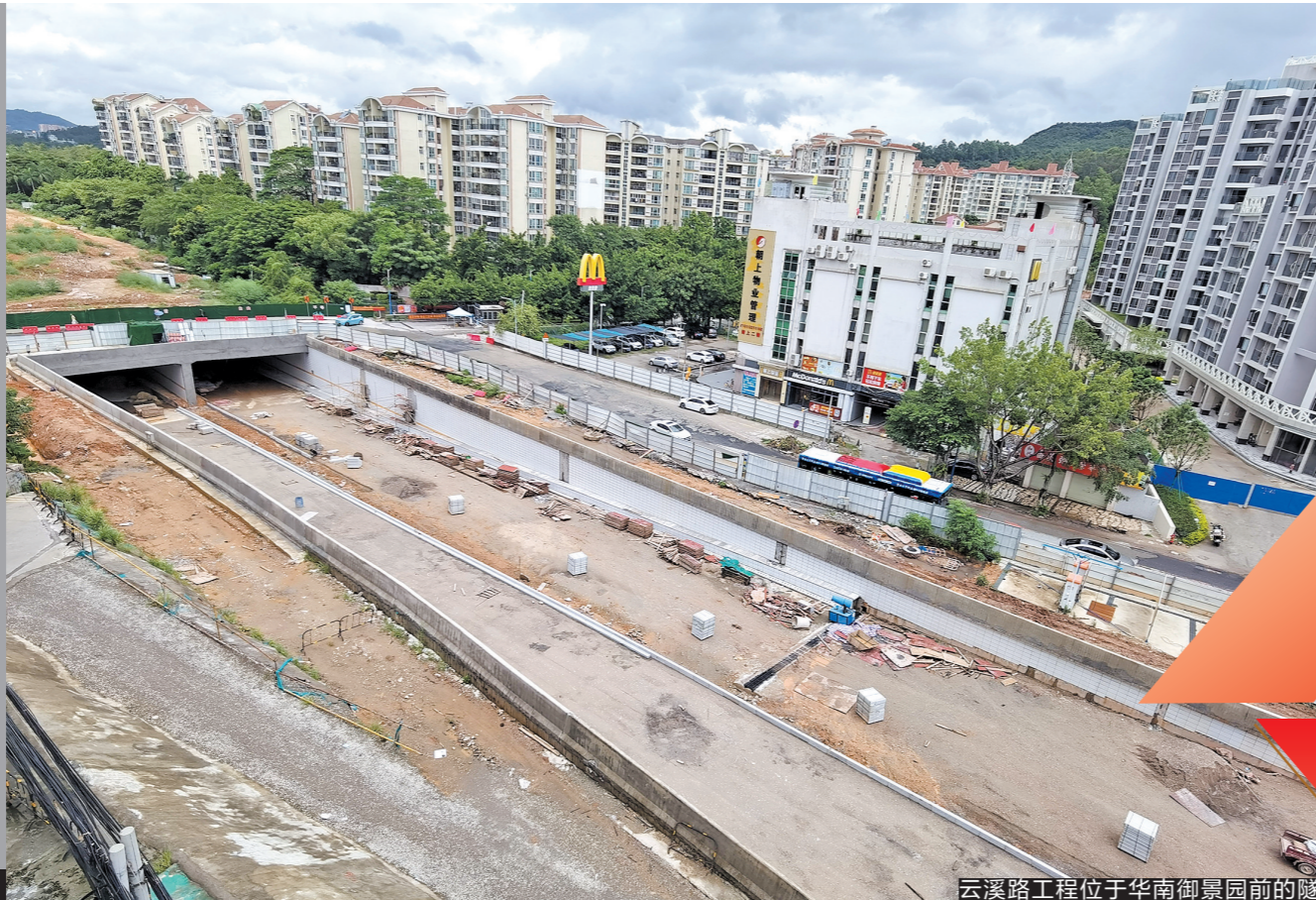
云溪路工程位于华南御景园前的隧道
